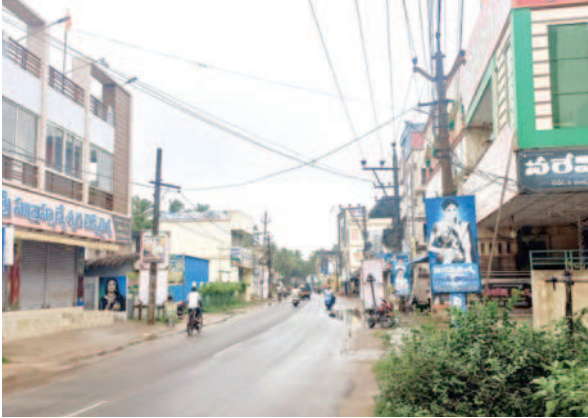
ఆమలాపురంలో నిర్మాణస్వంగా ఉన్న రోడ్డు
